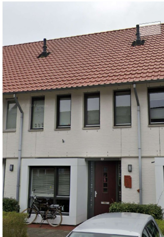
FOTO VOORGEVEL WONING TE PLAATSSEN DAKKAPEL
