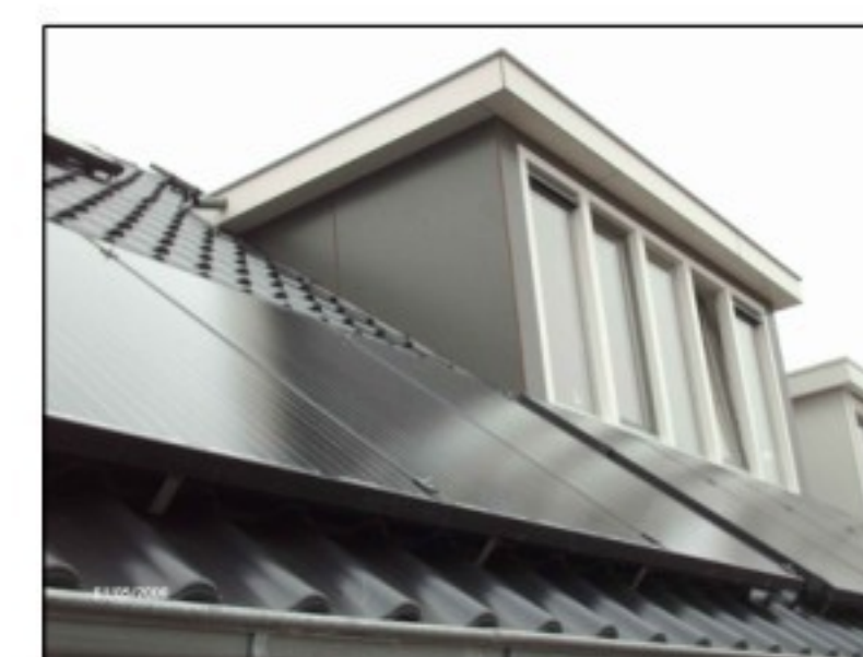
Bestaande dakkapel achtergevel
