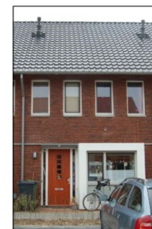
Bestaande situatie voorgevel
