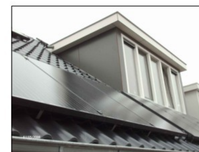
Bestaande dakkapel achtergevel
