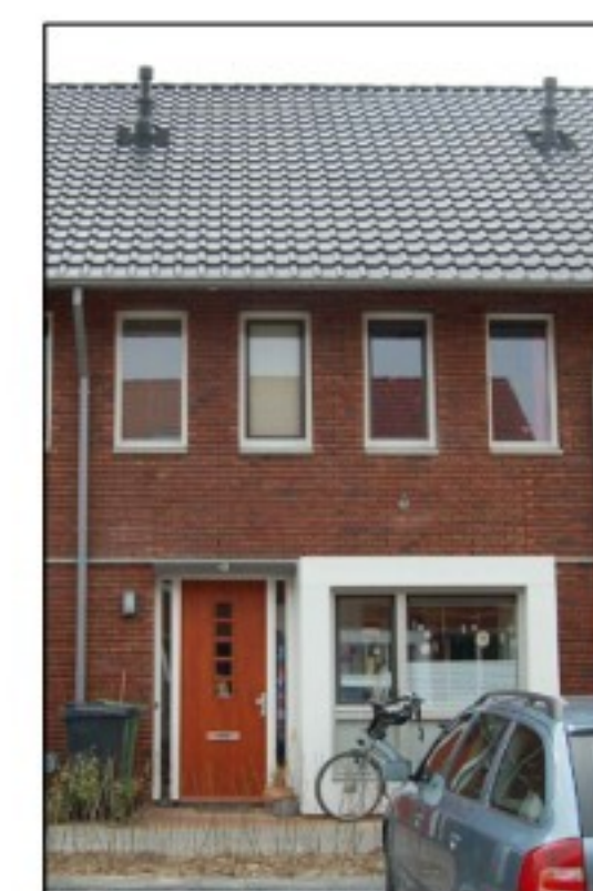
Bestaande situatie voorgevel
